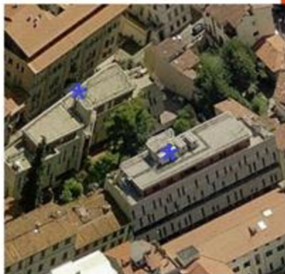
Vista verso Ovest
